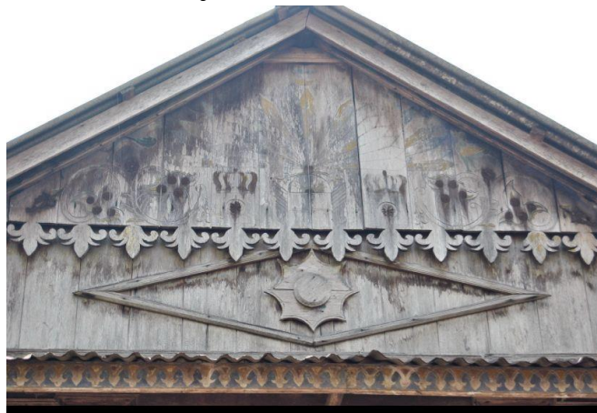
Gambar 1. Bidang tebar layar pada fasad Rumah Tuo Rantau Panjang. Sumber: Dokumentasi pengguna, 2026.
